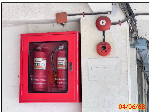
รูปที่ 2.2-11 ดับเพลิงแบบมือถือชนิดผงเคมีแห้ง
